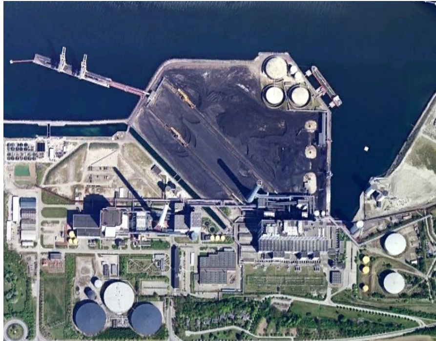
Figur 19: Asnæsværket set lodret oppefra i ca. 1,22 km højde. Nord for værket ses dets kulplads omkranset af værket havnefaciliteter. Kilde: Google 2010.
