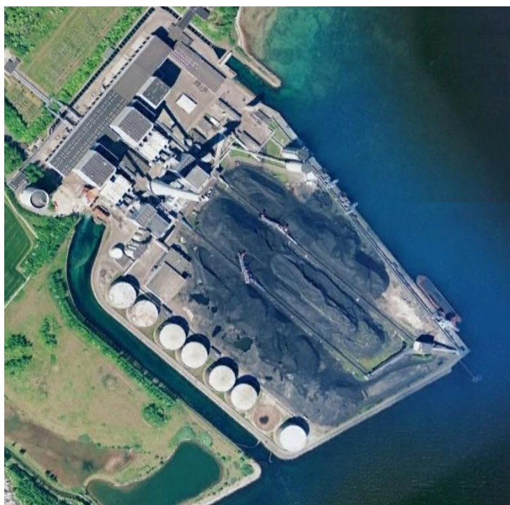
Figur 26: Studstrupværket og dets kulplads samt havnefaciliteter i Valø Vig, nord for Århus, set lodret oppe fra i 1,2 km højde. Af billedet fremgår et kul-lastskib med en længde på ca. 95 m. og en bredde på ca. 20 m. Kilde: Google 2010.
