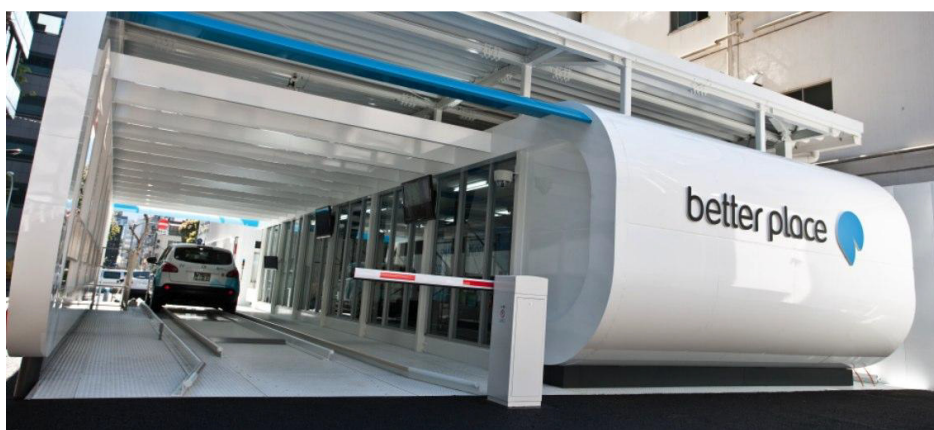
Figur 4 Batteriskiftestation fra Better Place.
