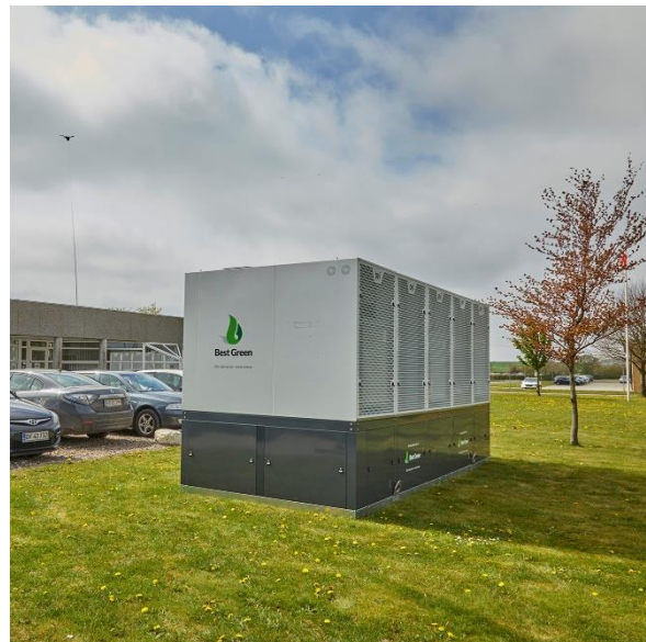
Figur 2: Varmepumpe af samme type som den installeret hos Bønnerup Strand Feriecenter
