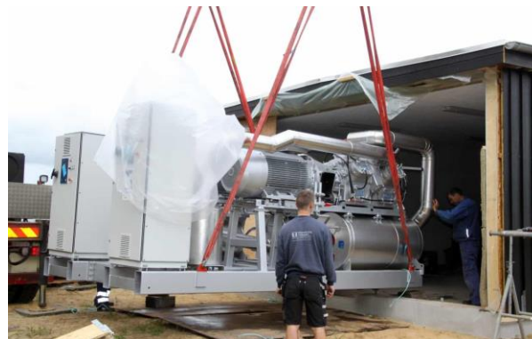
Figur 2: Installering af varmepumpen [ https://iv.dk/artikel/sig-varmeverk-f%C3%A6rk-f%C3%A5r-snart-kunderne-til-at-svede/ ]
