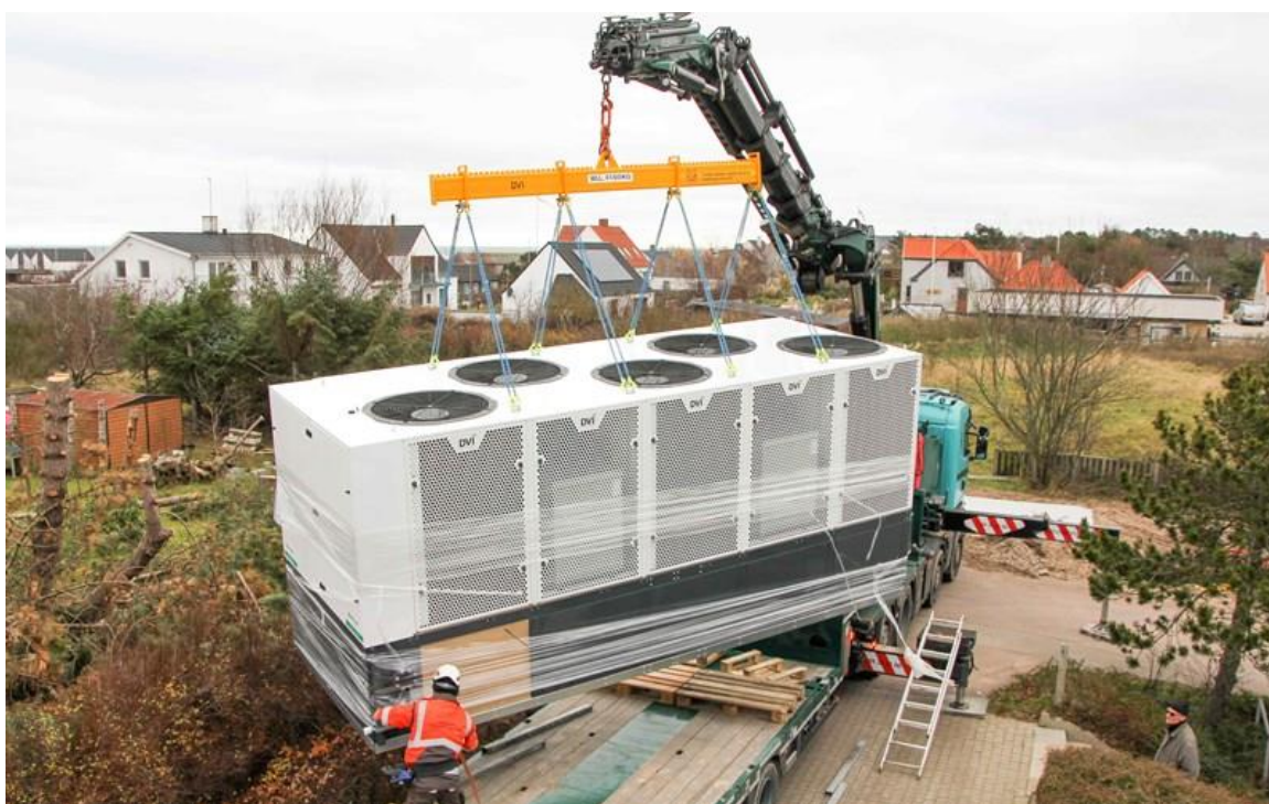
Figur 3: Installationen af varmepumpen hos Bønnerup Strand.
