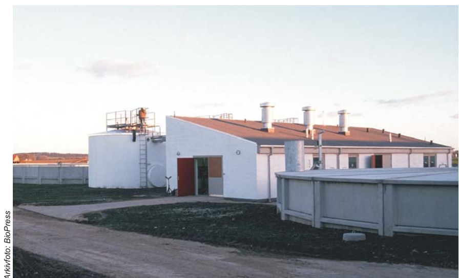
Revninge biogasanlæg på Fyn, som i en årrække forsynede byen med biogas i et særskilt gasnet. I perioder, hvor biogasproduktionen ikke kunne dække behovet, blev der suppleret op med en blanding af naturgas og luft.
